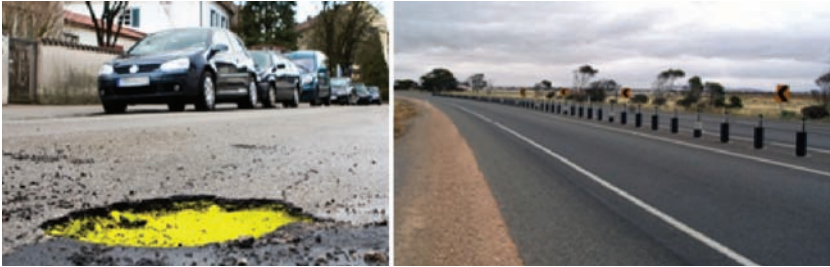
Слика 54. Ударна рупа на коловозу (лево) и уређен коловоз (десно)
